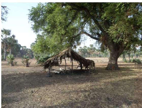
Photo n°3 : Forge rectangulaire avec toiture à dos de cheval
