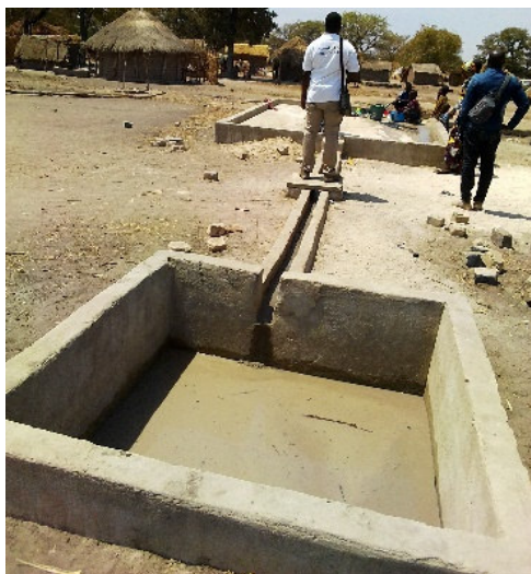
Photo 1. Dispositif d'aire de lavage construit au profit des réfugiés de Dilingala
