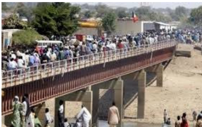
Photo 2. Intensité du trafic sur le pont de Nguéli
