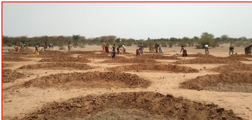
Photo n° 6. Mise sur pied de la technique des demi-lunes
