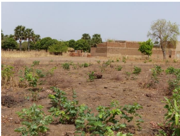
Figure 8: Vue sur une construction d'habitat depuis le site (cliché ABANGA, 2022)
