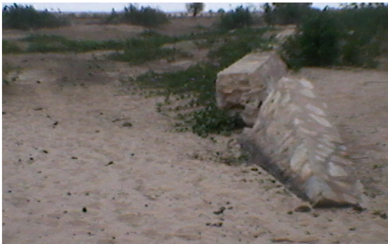
Photo 2 : Seuil d'épandage détruit par les eaux de ruissellement dans le Moyen-Chok
