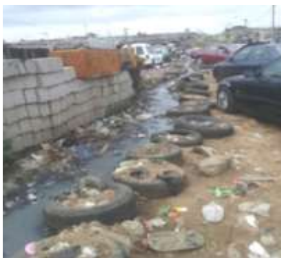
Photo 1 et 2 : Des déchets solides obstruant l'écoulement des eaux usées à l'air libre
