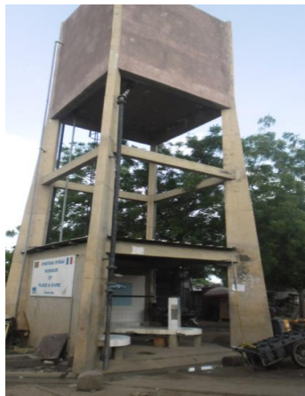
Photo 4 : Château d'eau communal financé par l'AFD au quartier Habbena,
