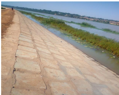
Photo 1 : Digue avec dallettes en béton
