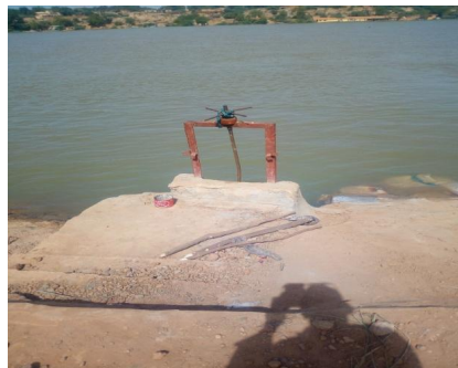
Photo 2 : Digue avec vanne de clapet anti retour à gauche
