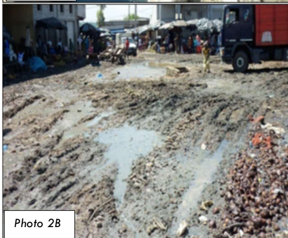
Planche photographique 1 : Collecteurs obstrués à Kôkô à Bouaké (photo 2A) et charge de boue au Marché Gouro d'Adjamé à Abidjan (photo 2B). Prise de vue N'GUETTA, E. 2025
