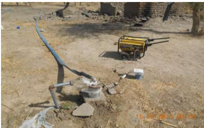
Photo1. Forage émergé et groupe électrogène à Gamal
