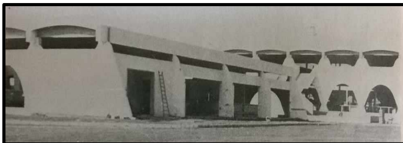
Photo n°2 : Vue intérieure du nouveau marché de Katiola
