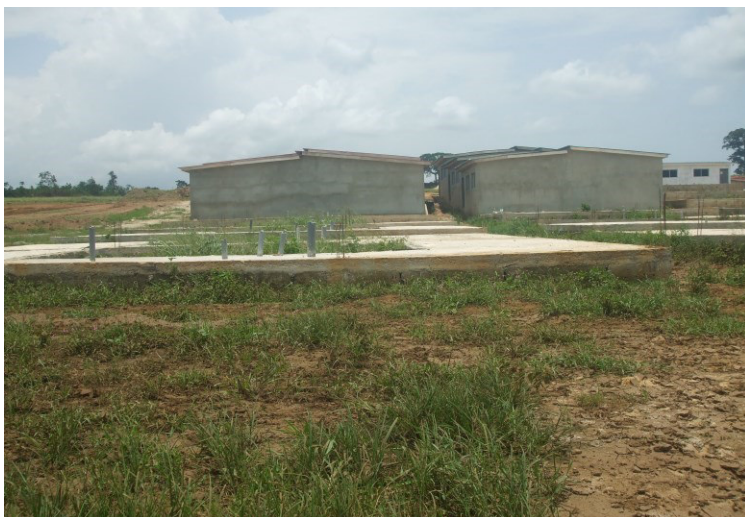
Photo 2 : Un exemple de fondations LEM et de logements
