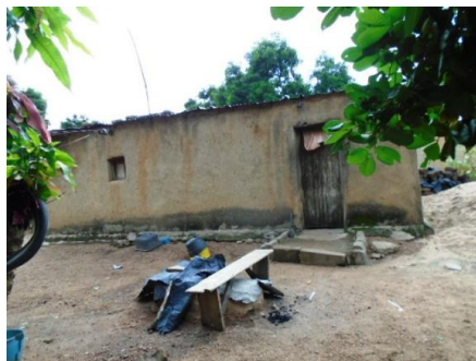
Photos 3 : Construction en banco Source : Nos enquêtes, 2017
